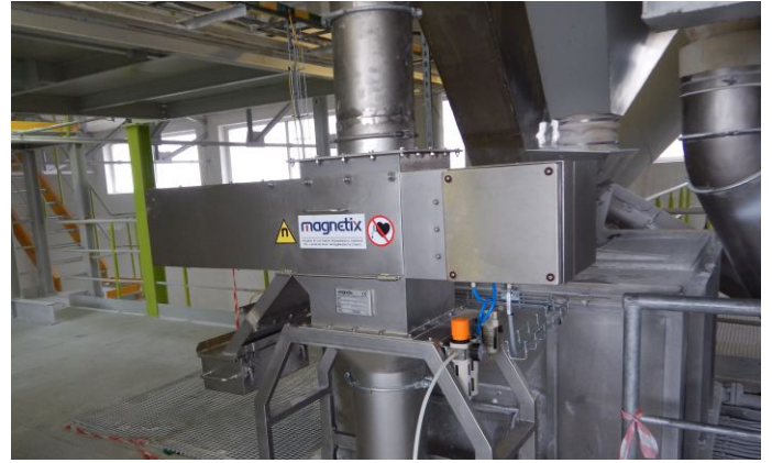
Usuwanie ferromagnetyków z cukru. Instalacja separatora przed silosem.
