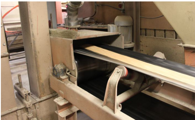
Usuwanie zanieczyszczeń żelaznych z kruszywa.
