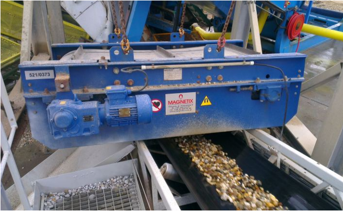
Usuwanie zanieczyszczeń żelaznych z kruszywa.
