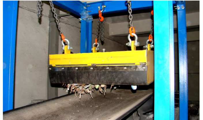
Usuwanie zanieczyszczeń żelaznych ze stłuczki szklanej.
